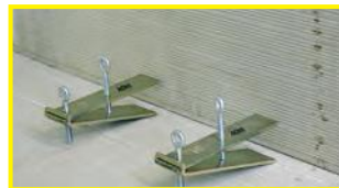
1º Posicionar niveladores.
