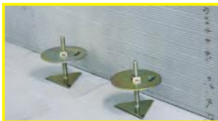
1º Posicionar niveladores.
